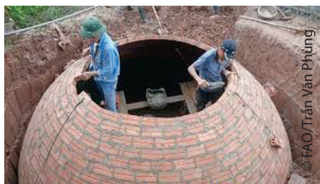
(1) Bể biogas xây bằng gạch;
