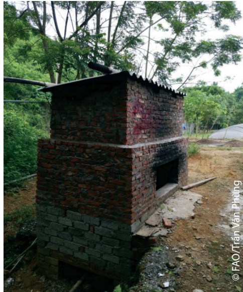
Hình 35. Lò đốt xác lợn chết sử dụng khí biogas
