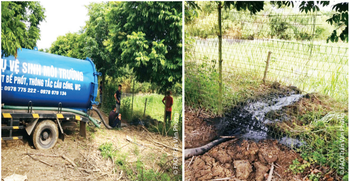
Hình 47. Hút và nạo vét cặn bể biogas
