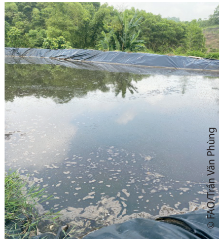
Hình 44. Bể sinh học
