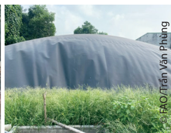
(3) Bể phủ bạt HDPE
